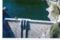
Kayabeyi Barajı ve Akıncı HES / 80,7 MW
